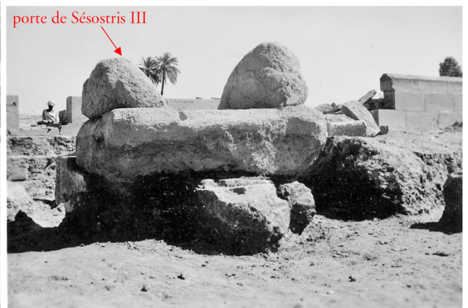
seuil et jambage en granite de Sésostris III posés sur les deux assises du radier calcaire
