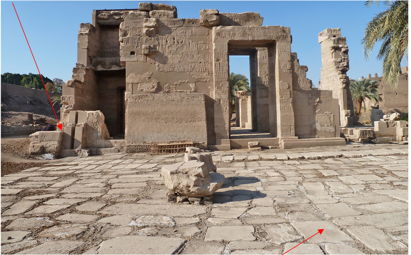
dallage reconstitué à l'aplomb du radier démantelé
