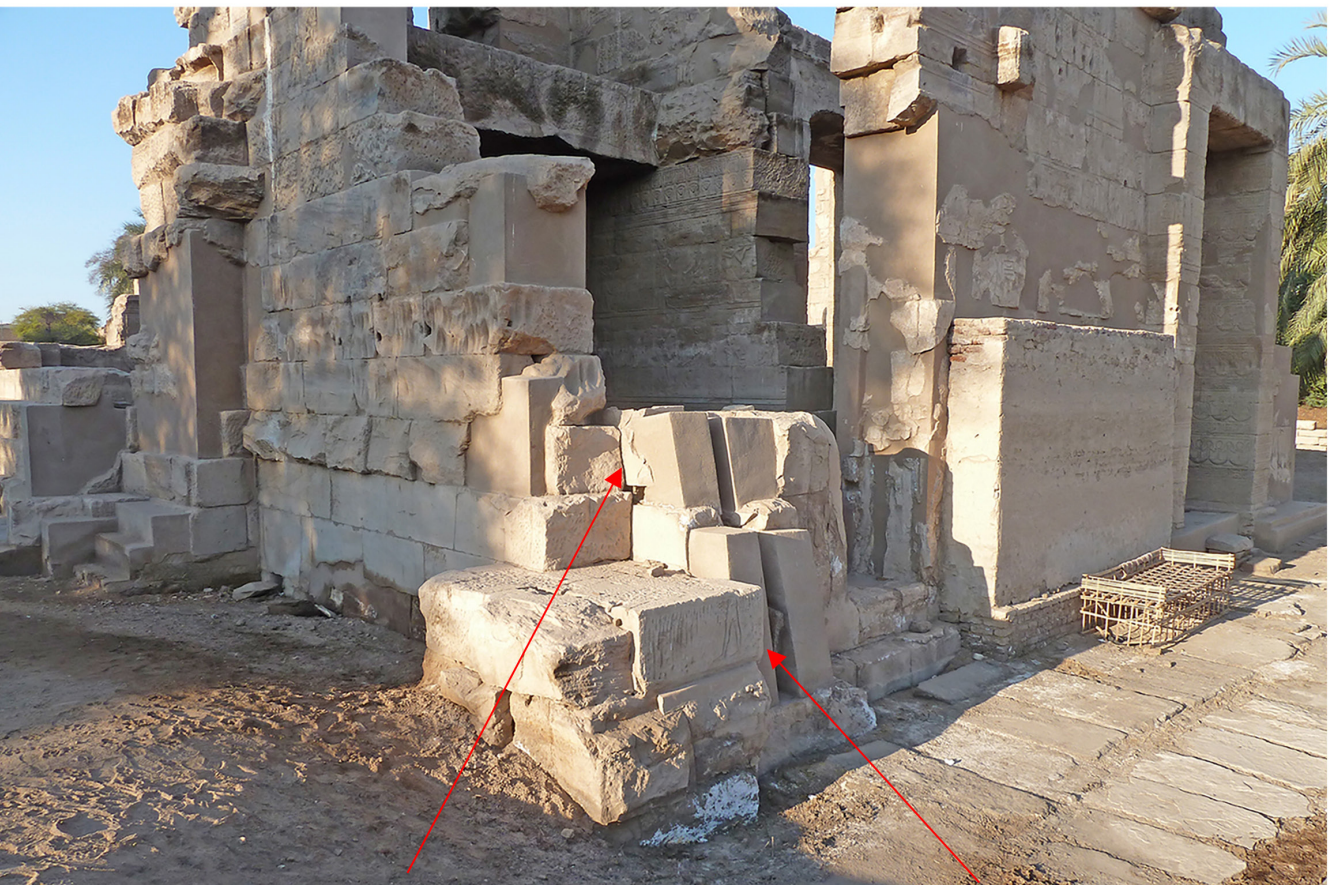
face de joint verticale du mur ptolémaïque adossé au tableau vertical de la porte de Sésostri 1 er
